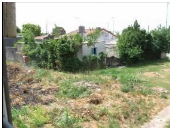
Operario con mochila pulverizadora. Línea Roca
